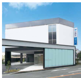
公益社 石橋会館 大阪府池田市(平成25年4月15日)
